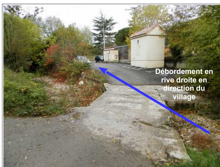
Figure III.6: gué du chemin du Rouquet. Le cours d'eau déborde en rive droite en direction du village.
