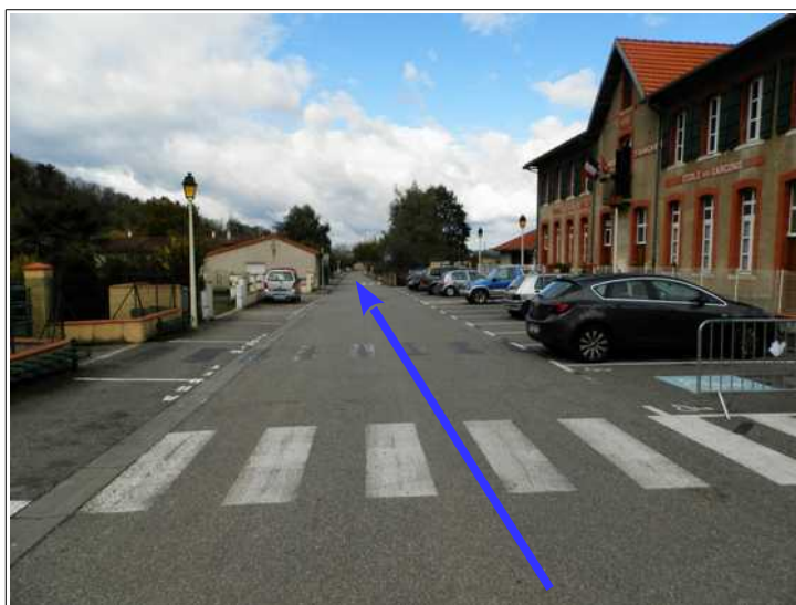
Figure III.8: les débordements peuvent se propager sur la rue des Ecoles devant la mairie puis sur la rue de la Pointe en arrière plan.
