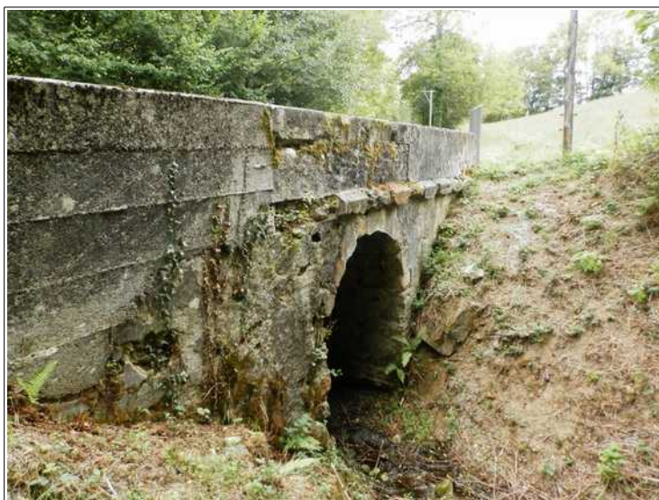
Figure III.14: pont de la RD331 à l'aval de Fourtet.
