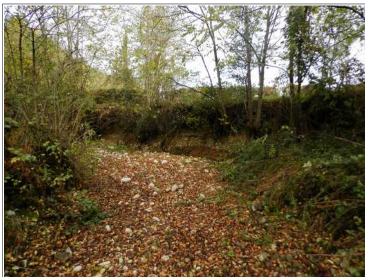
Figure III.2: berge érodée au droit du village.
