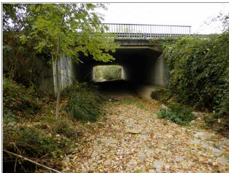
Figure III.11: pont de la voie rapide N20 (commune de Varilhès).
