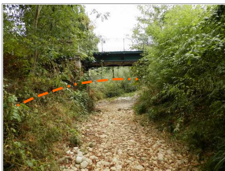
Figure III.4: pont de la RD331 au Rouquet. On notera son ouverture et le niveau de crue couramment rencontré.
