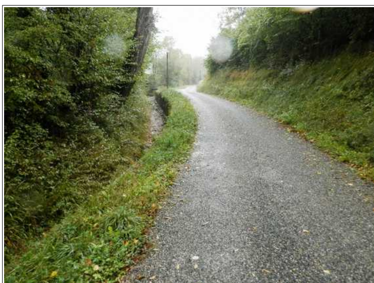
Figure III.15: le ruisseau de Ton longe la RD331 800mètres à l'amont de sa confluence avec le Méridic. A noter son chenal étroit.
