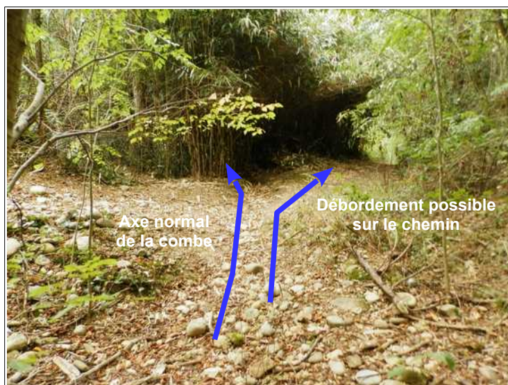
Figure III.19: débouché de la combe Ferranne. Une partie de ses écoulements peut emprunter le chemin rural à droite.
